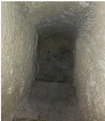
Photo 2 : Foyer chaudière avant les travaux
